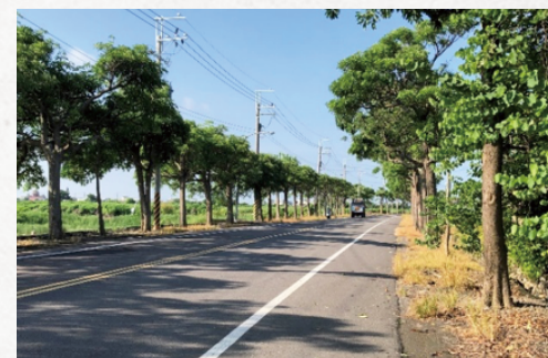
聯外道路除草作業
