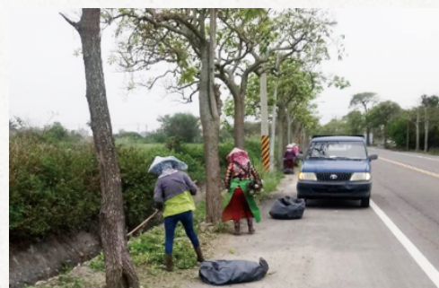
聯外道路除草作業
