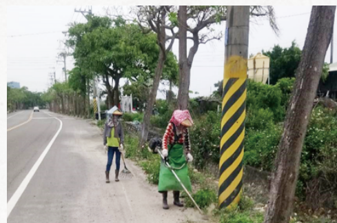
聯外道路除草作業
