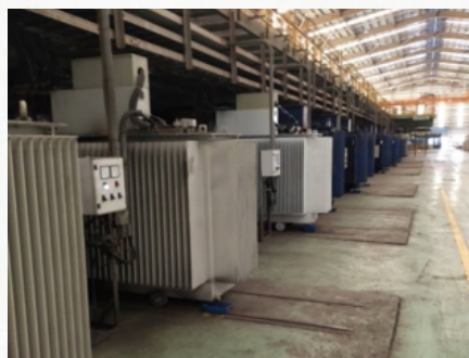
APL電解段NO.3整流變壓器汰舊換新
